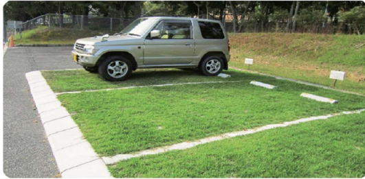
マットタイプはアスファルト舗装面への直置き施工が可能
