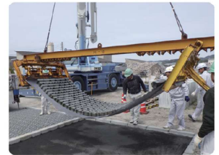
クレーン車でシート単位に敷設
