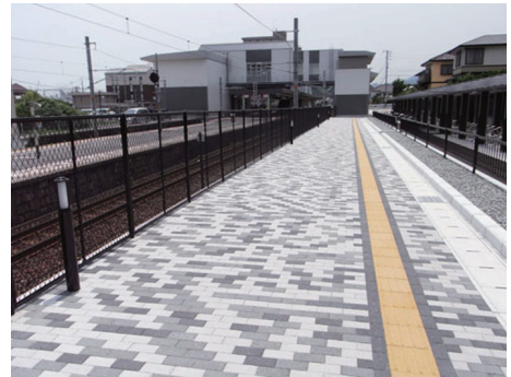
■ 市道長府末小田本町自歩道1号線（下関市）
