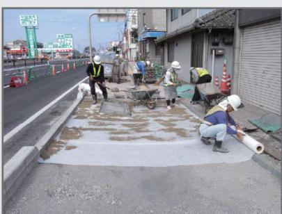
雨水の浸透に伴って敷砂が路盤内に流出する恐れがあるため路盤上(敷砂の下面)に不織布を敷設します。連続して敷設する場合の重ね幅は10cm程度とします。
