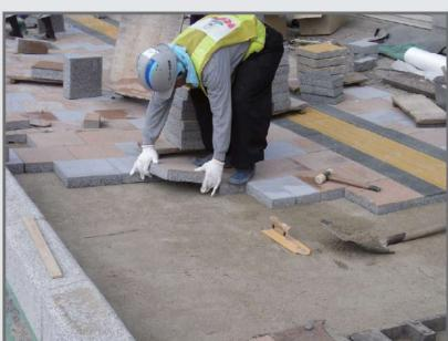
ブロックを敷設し始める基準線を水糸や縁石等で設定します。目地の通りを確認しながら、ブロックの敷設を行います。
