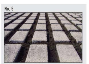
ブロックの敷設が完了したら、客土をブロックの隙間に芝生を張りつける厚さを考慮し、充填していきます。
