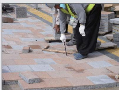
目地ラインや目地幅の調整を行い、所定の目地幅でブロック相互を十分にかみ合わせることで、荷重分散性能の向上と美観を図ります。目地通りの修正には、バールやドライバなどを用いてブロックを移動させます。
