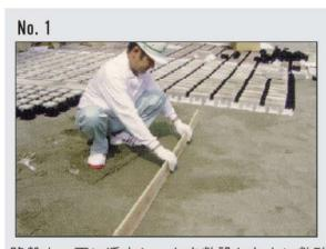
路盤上一面に透水シートを敷設した上に敷砂を凹凸ができないように平坦に均し、十分に転圧を行います。舗装の平坦性は、敷砂の平坦性で決まります。
