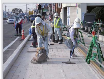
ブロックの表面に目地砂を均一にまき、ほうき、またはデッキブラシなどで表面を掃くようにして砂を目地にすり込みます。コンパクタの振動を併用すると効果的です。目地詰めは目地に目地砂が十分充填されるまで繰り返します。
