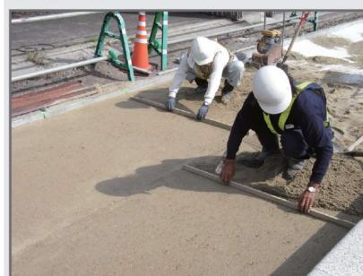
舗装面の設計基準高さからブロック厚さを引き、これに敷砂の余盛厚を加えた厚さを基準にして水糸を張り、敷砂の仕上げ高さを決めます。ならし板を用いて敷砂を平らになります。
