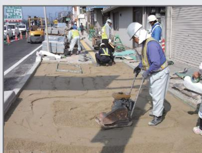
敷砂の仕上がり厚さに余盛厚を加えた厚さで路盤上に敷砂を敷きならした後、プレートコンパクタを用いて敷砂を締固めます。
