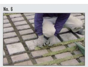
ブロックとブロックの間に合わせカットした芝生を隙間なく張りつけ、踏圧により芝全体を踏み固めます。
