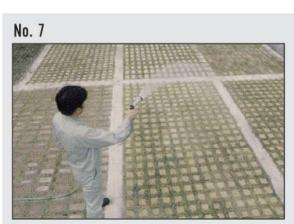
芝に自土を散布し、芝に馴染ませて灌水をします。この時ブロックに付いた客土、目土等の汚れも同時に洗い流します。
